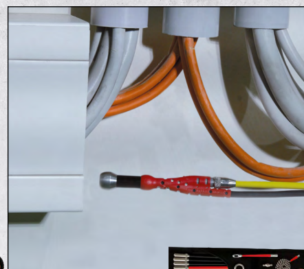
Pozos y canales subterráneos
